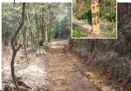
荒廃していた肥中街道を再生
