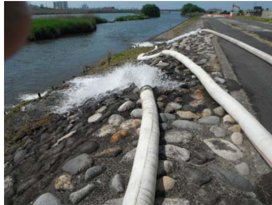
排水ポンプ車による排水作業状況
