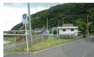
袋川〈湯所川排水機場〉
