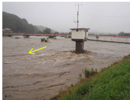
八東川出水状況 H23 台風 12 号 (鳥取市河原町今在家 片山水位観測所)
