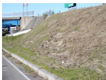
千代川 堤防法面損傷 (H16 台風 21 号)
