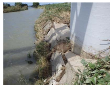
千代川 低水護岸沈下 (H30.7 梅雨前線豪雨)
