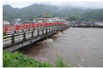
平成30年7月7日洪水 用瀬町中橋付近
