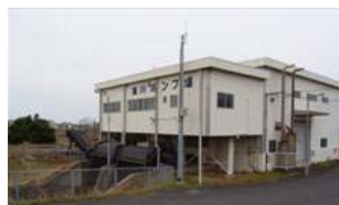
袋川〈狐川排水機場〉
