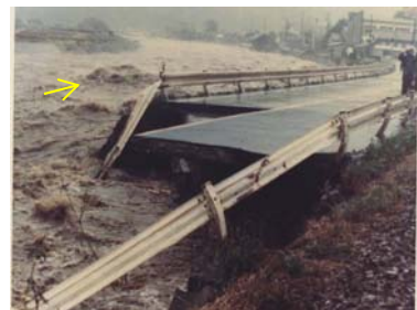
昭和 54 年 10 月 18 日洪水 浸食された道路(安蔵付近)
