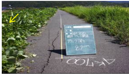
平成22年9月旱天亀裂 (新袋川・袋川 左岸 中郷付近)
