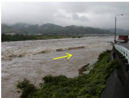
千代川出水状況 H16 台風 21 号 (鳥取市円通寺 大口堰下流)
