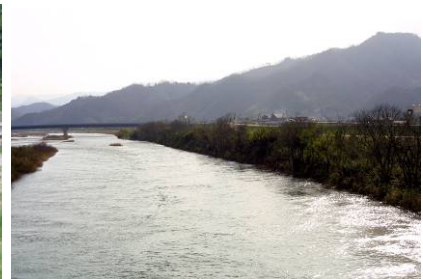
稲常橋上流付近
