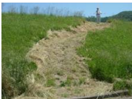
人為的な堤防法面の損傷
