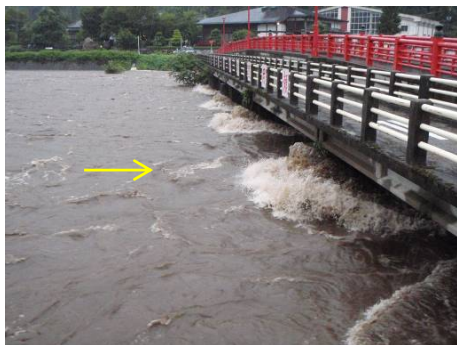
千代川出水状況 H23 台風 12 号 (鳥取市用瀬町用瀬 中橋、雛橋)
