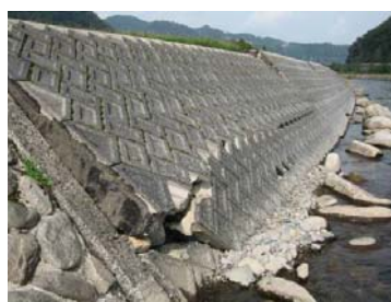
千代川 護岸亀裂 (H23 台風 12 号)
