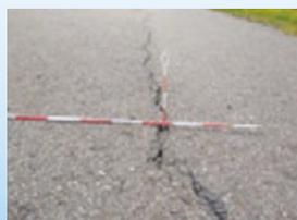
▲堤防の舗装に亀裂
