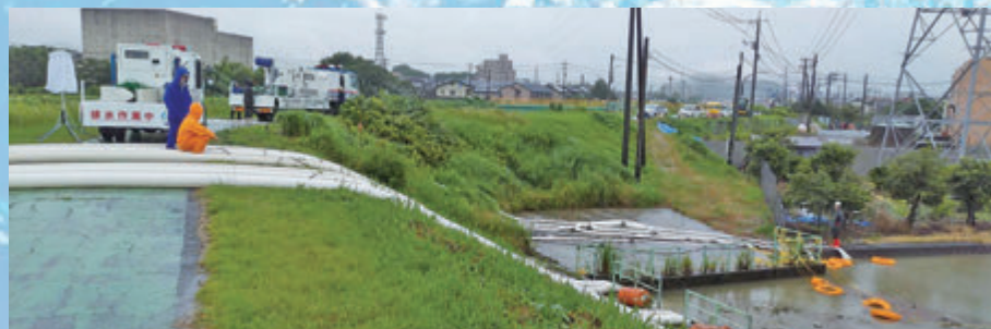
▲ 排水ポンプ車を使用した排水作業の状況(令和3年7月8日鳥取市吉成南町での排水作業)
