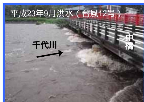
鳥取市用瀬地区(中橋)の増水状況
