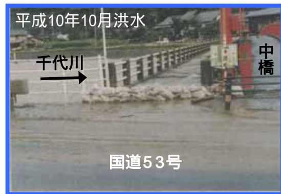
鳥取市用瀬地区(中橋)の増水状況
