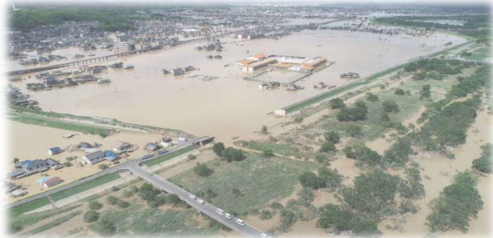
平成30年7月豪雨時の倉敷市真備町の上空写真（写真提供：国土交通省 中国地方整備局）
