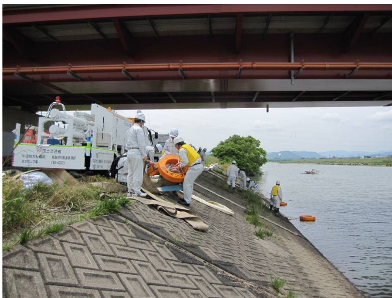
排水ポンプ車による排水訓練(千代川)
