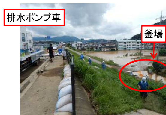
平成26年8月広島豪雨災害における 排水ポンプ車の活動状況
