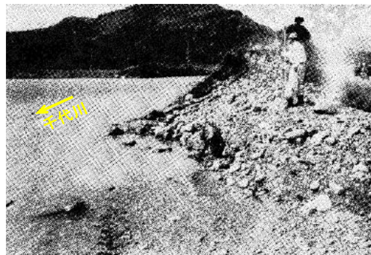
破堤状況(鳥取市河原町/曳田川合流点付近)
