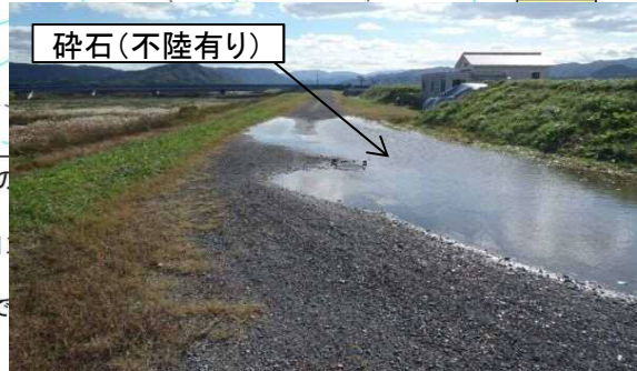
舗装前の堤防天端状況
