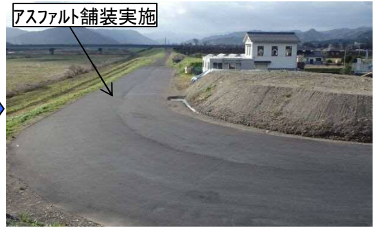
舗装後の堤防天端状況
