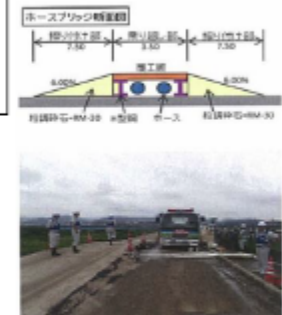
【ホースブリッジ完成】 排水ホース上を車両が通行する ための対策例 (ホースブリッジ) (H26年8月豪雨(中国地整))
