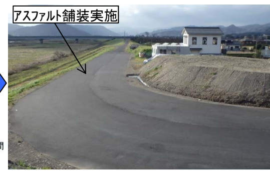
舗装後の堤防天端状況
