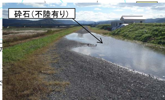
舗装前の堤防天端状況
