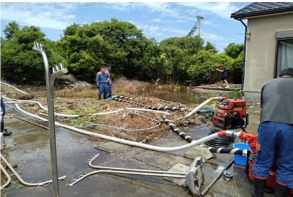
排水作業の様子
