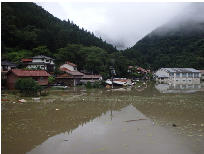
浸水被害 島根県江津市川越
