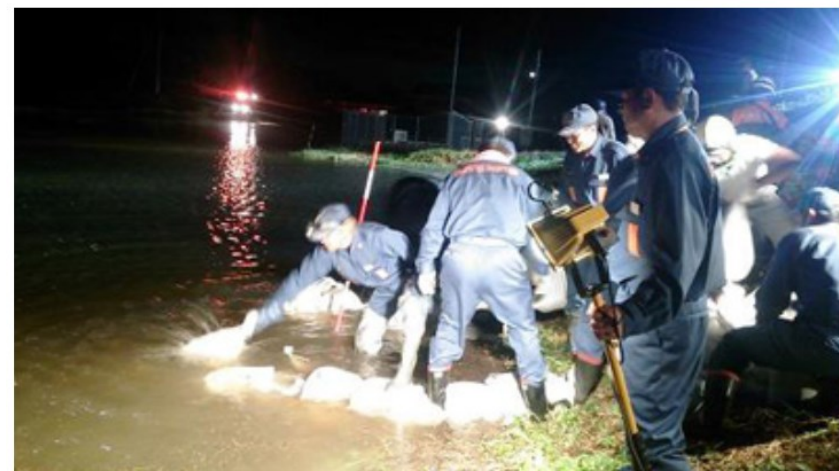
小貝川での水防活動の様子 (平成26年10月 茨城県筑西市消防団) 【出典：国土交通省 HPより】
