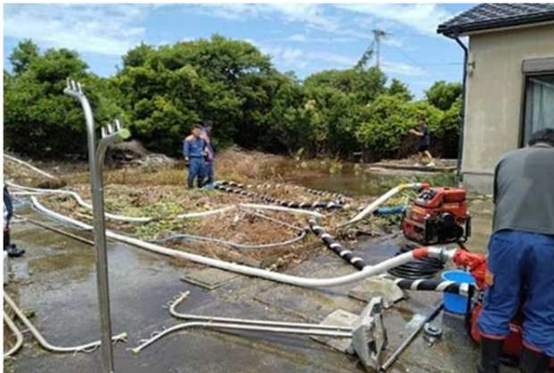
排水作業の様子
