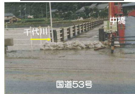
鳥取市用瀬地区の増水状況
