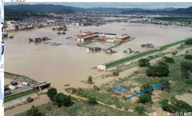
左岸3k400破堤状況
