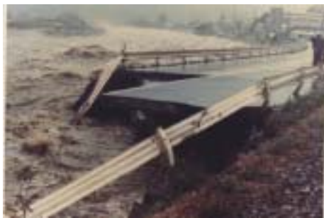
昭和54年10月洪水 浸食された道路(安蔵)
