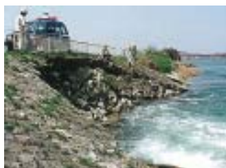
被災箇所での河川巡視
