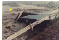
昭和54年10月18日洪水 浸食された道路(安福付近)
