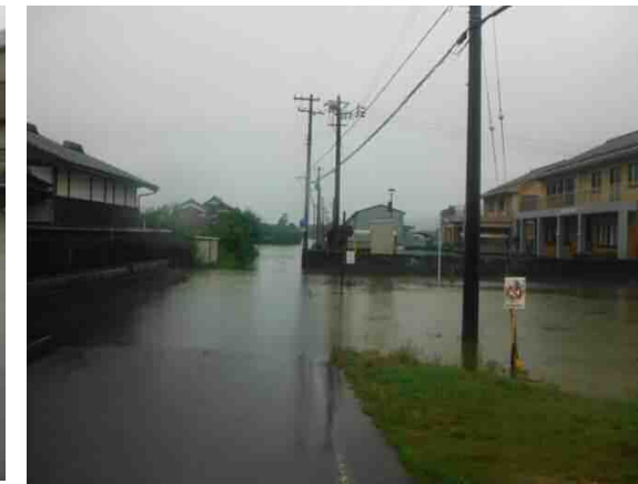
② 堤内地冠水（鳥取市下味野）
