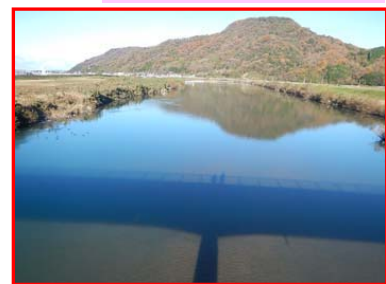
稲常橋上流付近
