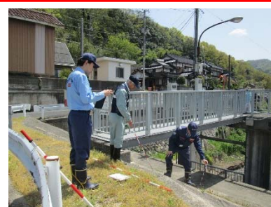
写真 5.2.7 排水樋門の点検
