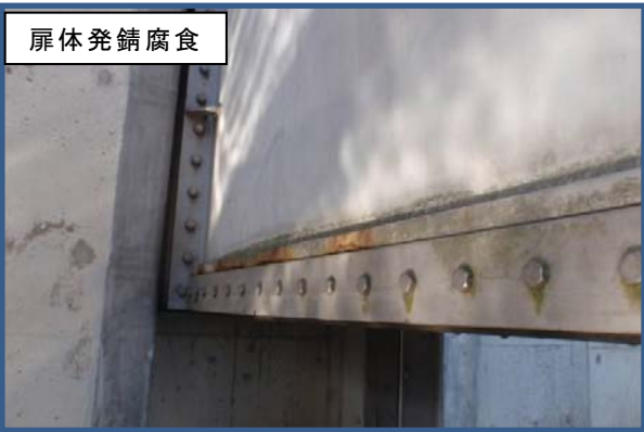
写真 2.4.5 樋門ゲートの劣化
