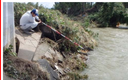
写真 5.2.4 被災箇所の測量 (平成30年7月洪水：国安付近)
