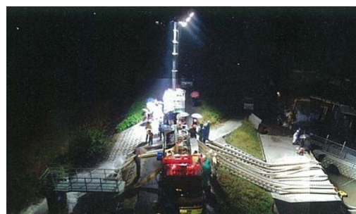
写真 5.2.8 照明車と排水ポンプ車
