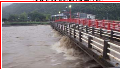
平成30年7月7日豪雨(梅雨前線) 増水状況(用瀬町中橋付近)
