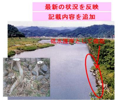
写真 1.2.2 護摩土手の法面の石積と見られる跡と石を抱き込んだヤナギの根（稲常橋上流）
