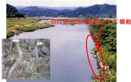
護摩土手の法面の石積と見られる跡と石を抱き込んだヤナギの根(稲常橋上流)
