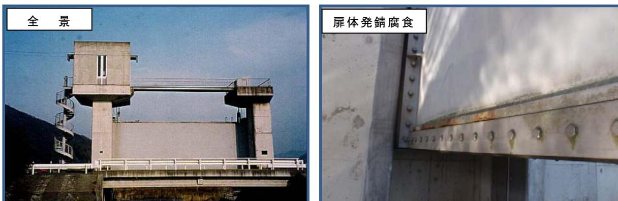
写真 2.4.5 樋門ゲートの劣化
