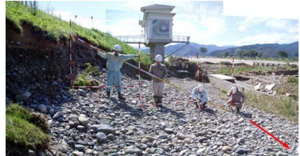
写真 2.4.2 平成16年9月洪水による堤防の崩壊状況(倉田スポーツ広場付近)
