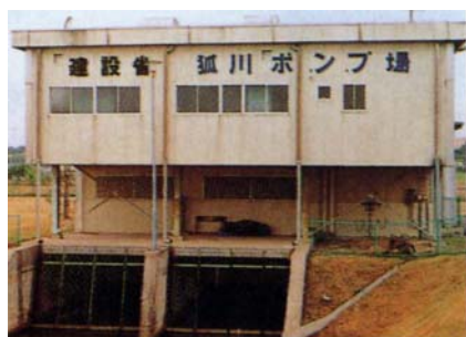
写真 2.4.3 今後、機器類の更新が必要な排水機場
