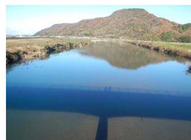
稲常橋上流付近
