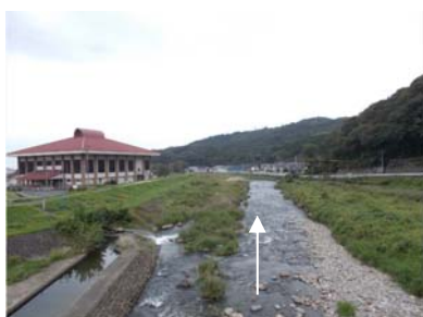
写真 2.3.9 新袋川 国府中央橋付近
