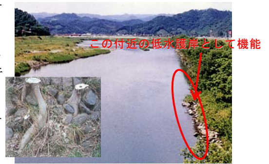
護摩土手の法面の石積と見られる跡と石を抱き込んだヤナギの根(稲常橋上流)
