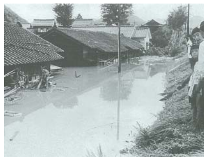
昭和34年9月26日洪水 水に沈んだ家屋(立川二丁目付近)
