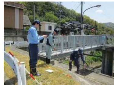
写真 5.2.7 排水樋門の点検
