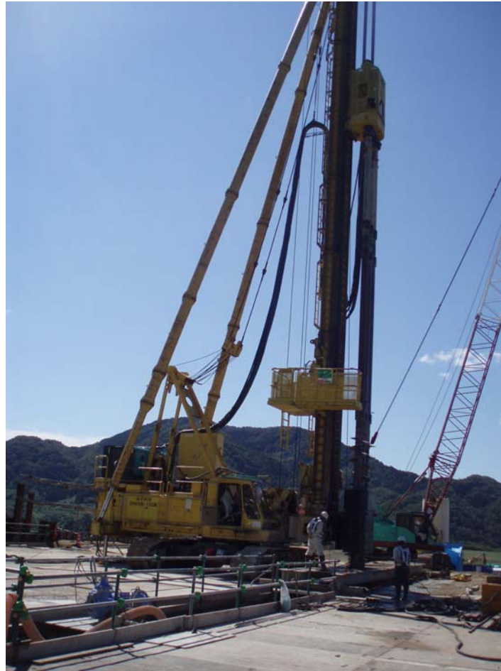
塩見川橋橋台施工状況
