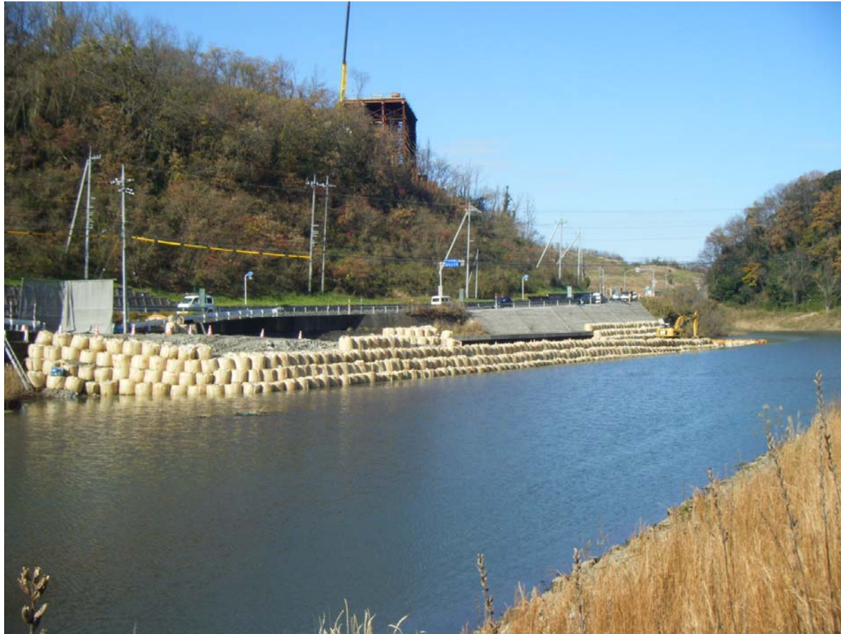
塩見川橋 橋脚仮設進入路施工状況
