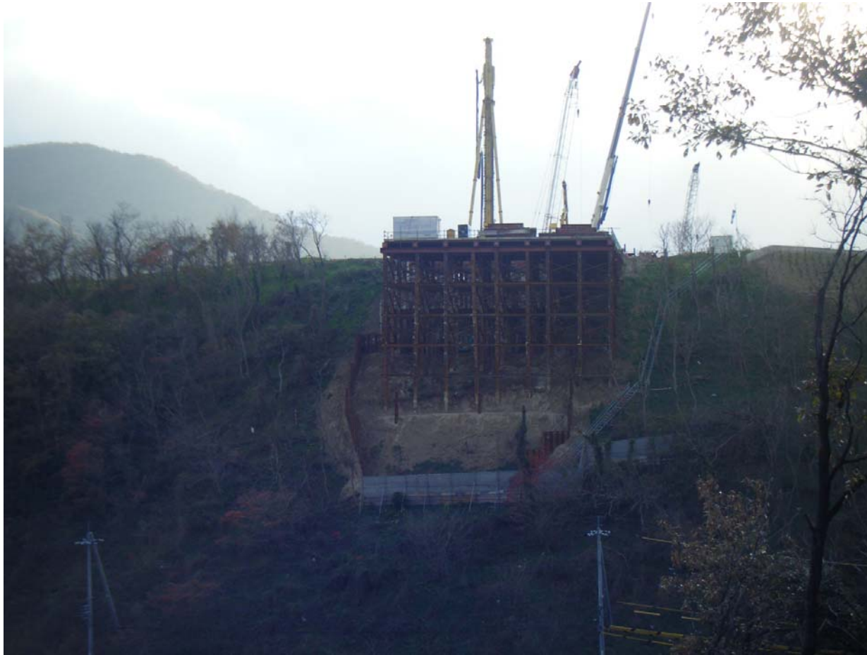
塩見川橋 橋台床堀施工状況
