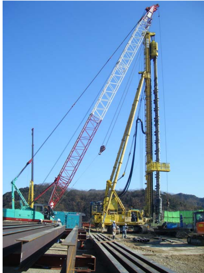
福部砂丘トンネル 地中連続壁施工状況
