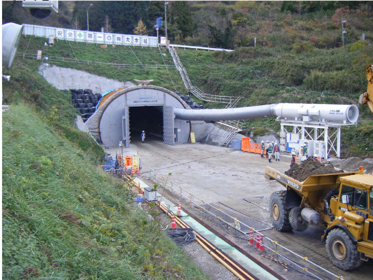
駟馳山トンネル 東側坑口付近施工状況
