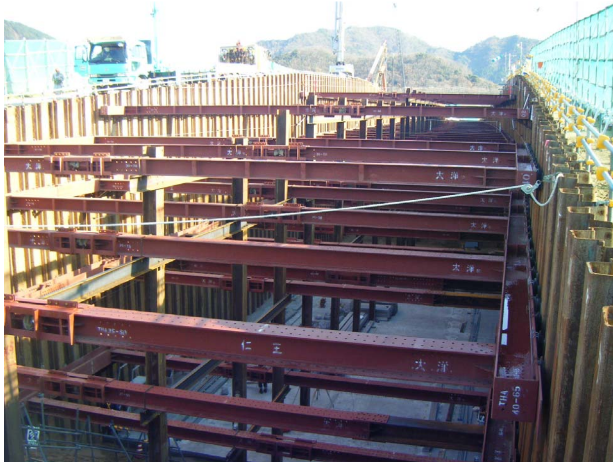
福部砂丘トンネル 鋼矢板設置施工状況
