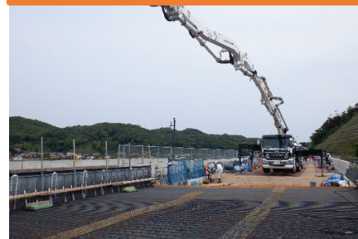
有富川橋鋼上部工事の様子
