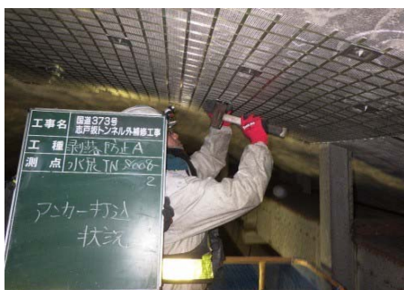
トンネル補修中
