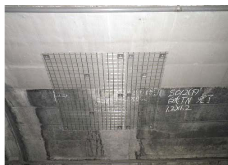
トンネル補修後
