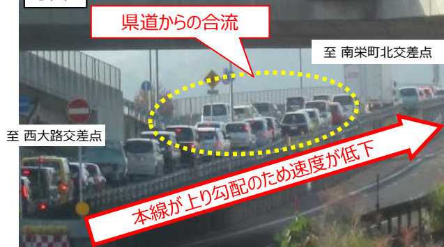
▲県道卯垣正蓮寺線との合流状況
