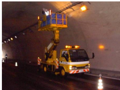
トンネル点検状況
