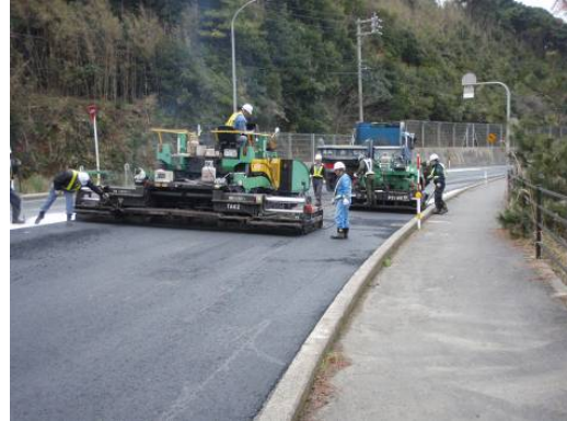
舗装修繕状況
