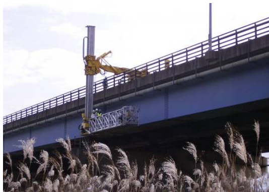
橋梁点検状況
