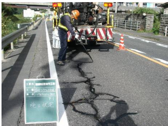
シール材注入状況
