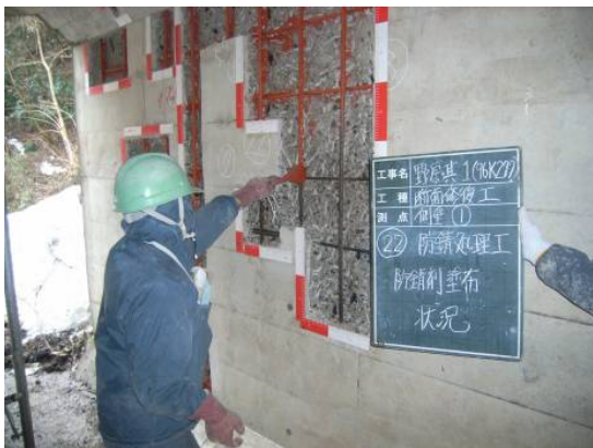
ボックスカルバート補修状況
