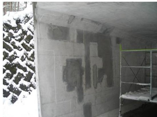
ボックスカルバート補修状況
