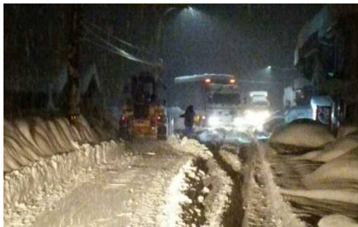
■国道373号(智頭町大内地内) 狭小な小型ドーザにより排雪し車両を移動
