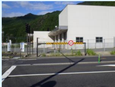
既設遮断機（手動）
