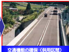
交通機能の確保（供用区間）
