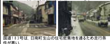
【供用前の国道183号】
