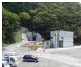
建設中の長尾トンネル
