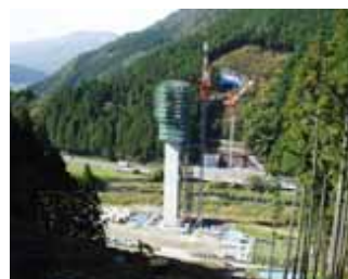
建設中の毛谷高架橋
