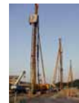
地盤改良工事の状況
