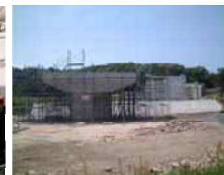
建設中の洗川橋
