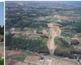
空からみた状況
