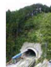
建設中の智頭トンネル
