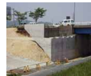
因幡大橋拡幅の拡幅橋台
