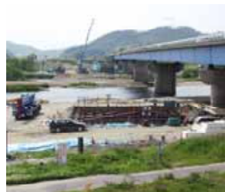
拡幅中の因幡大橋
