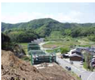
建設中の青谷羽合道路アクセス部
