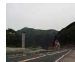
建設中の智頭高架橋
