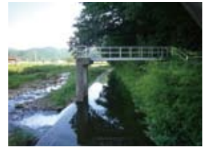
石山用水取水堰
