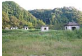
旧美歎水源地水道施設
