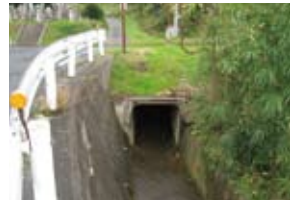
津ノ井のトンネル水路
