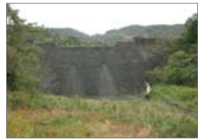
美歎水源地堰堤 （現在砂防堰堤に改良）
