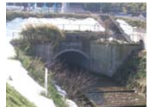
大杵樋門（袋川側）
