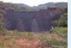
水源地堰堤（現在砂防堰堤に改良）
