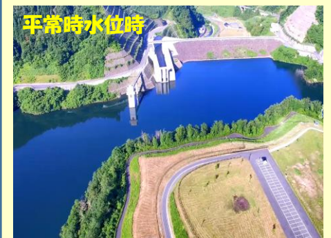
上空から見た殿ダム(ドローン撮影)
