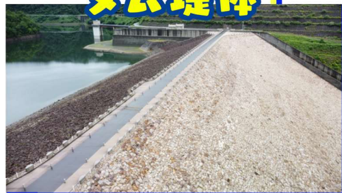
てい たい ダム堤体
