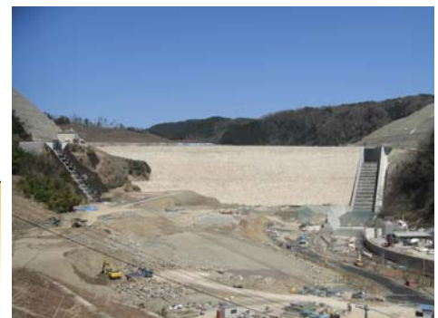
【殿ダム下流側からの眺望 H23. 4】
