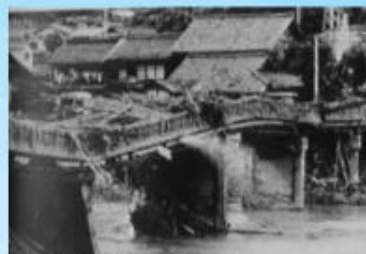
落壊しかけた要屋構。
