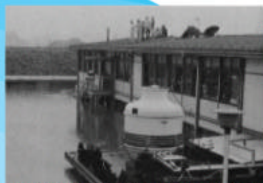
1階部分が完全に水に浸かっている2階建ての建設省三次工事事務所。昭和47年7月12日7時
