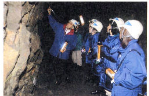
※1 横坑の見学 横坑とは、地層がどのようなかを実際目で見て、手で触れて調査するために掘られた横穴のこと。(今回の場合、長さ約50m、縦・横約2mほどの大きさで、大人が1人通れるほどの横穴を掘り調査しています。)
