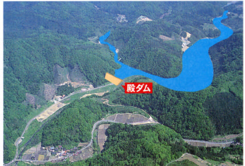
※3 殿ダムは、鳥取市及び国府町の住民の方に、安定した飲み水や工業用水を提供すると共に、川に住む生物たちの住みか(川の環境)を守り、大雨の時には川の水の一部をダムにためて(洪水調節)洪水の被害を小さくします。また、ダムから流す水を利用して電気を作ります。このように多目的な働きをする殿ダムは平成23年度末に完成する予定です。
