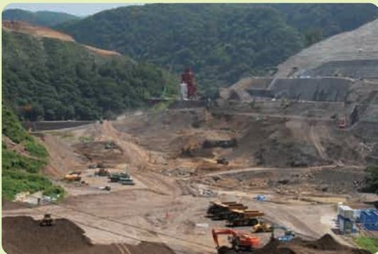
殿ダム堤体を築く場所を強い地盤にするため、谷の両側と川底の面を硬い岩盤まで掘り進める基礎掘削を行いました。(撮影:H20年8月)
