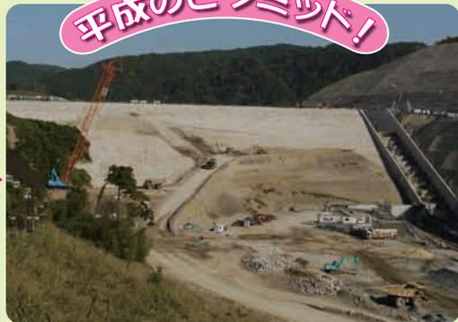
高さ75mの堤体がほぼ完成しました!現在、工事用道路の土砂を取り除く作業を行っています。(撮影:H22年11月)
