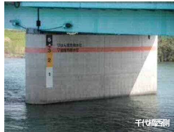
橋脚に水位表示した例
