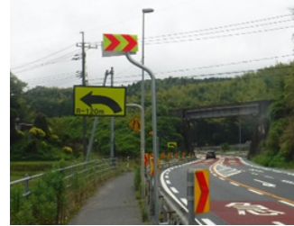
写真-3 大型車用視線誘導標
