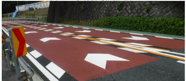
写真-2 カラー舗装施工後
