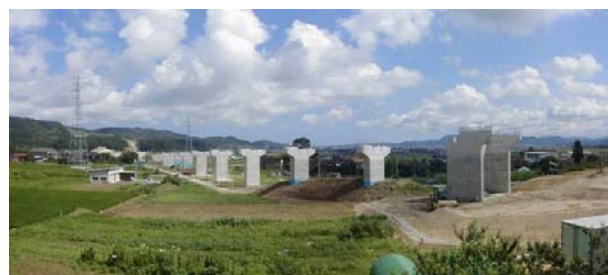
中国横断自動車道 姫路鳥取線 鳥取市(倭文高架橋付近)の整備状況
