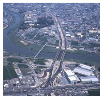
岡山西バイパス起点部(岡山市古新田地内)
