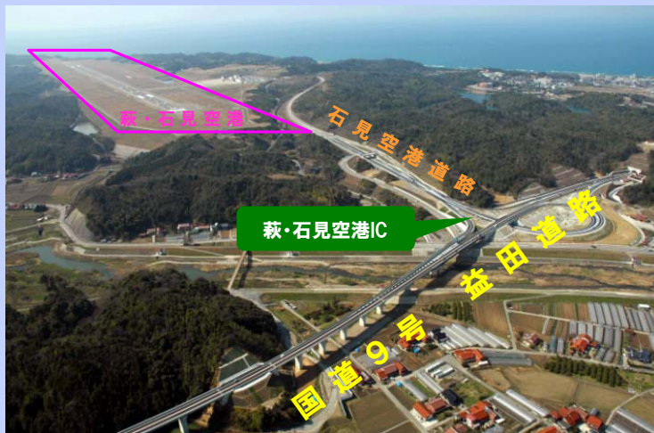
国道9号益田道路と石見空港道路の整備状況
