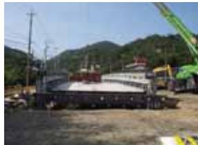
国道262号 上勝坂橋の被災 仮橋による復旧作業
