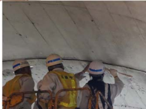
▲ トンネル点検状況
