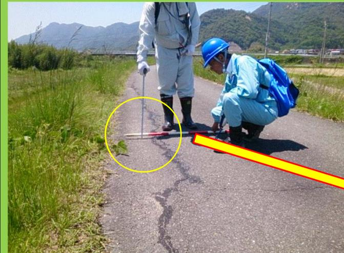
堤防上の舗装が沈んでいる場合、その沈み込みが年々拡大していくのか否かを確認するため、スケールを当てて沈み込みの量を測定しておきます。
