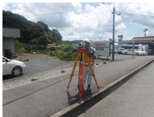
H29測量作業状況
