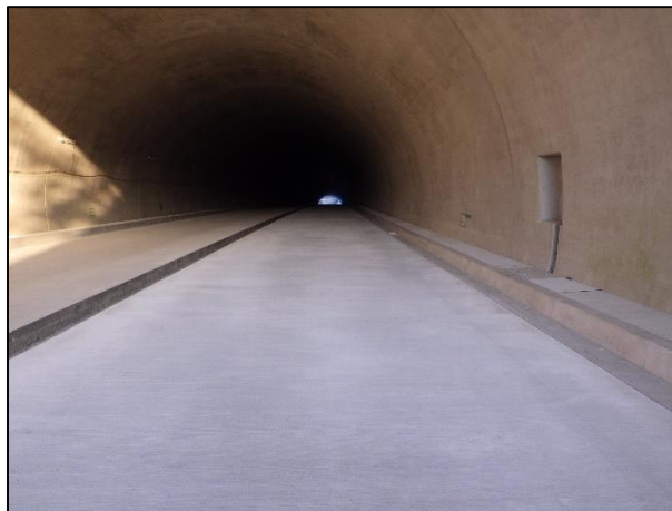
コンクリート舗装
