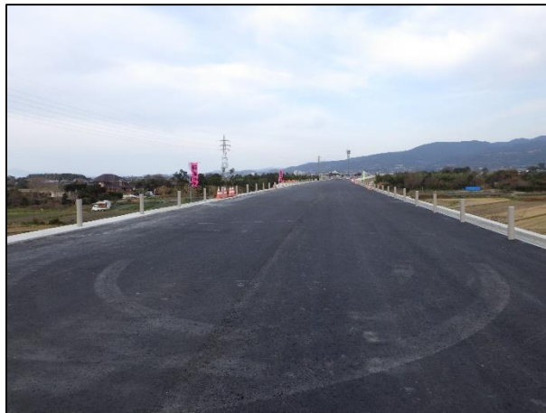
アスファルト舗装
