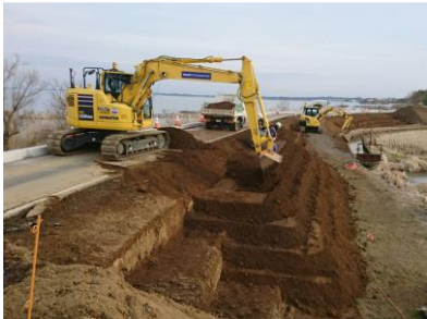
盛土・撒き出し
