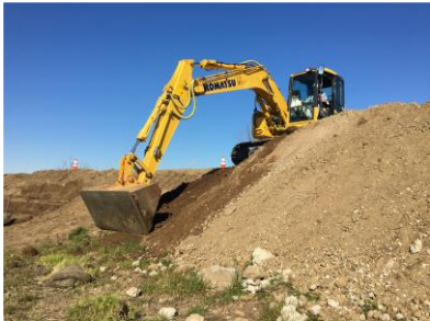
仮置き土撤去
